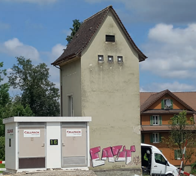
Turmstation vor dem Umbau, mit Stations-Provisorium von CPS
