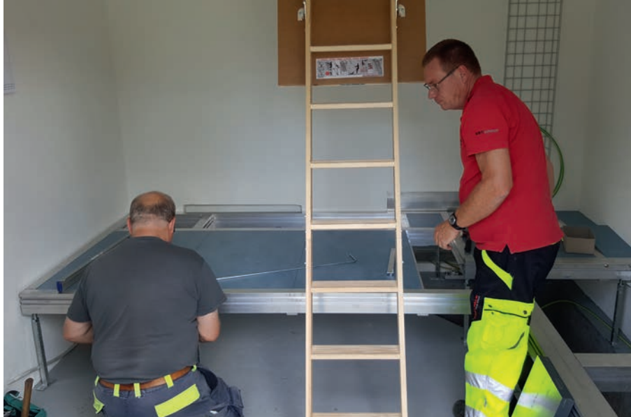
Einbau des Blindbodens durch Mitarbeitende der BBC Cellpack Power Systems
