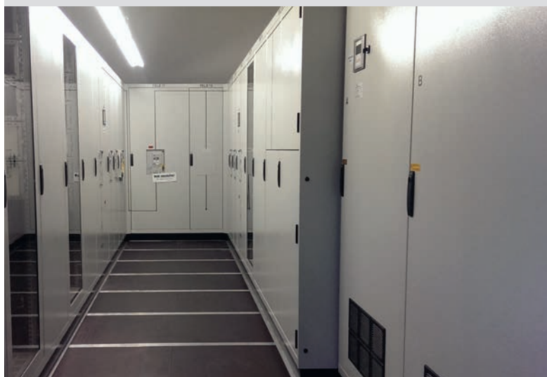
Niederspannungsverteilung nach SN EN 61439-2, 3200 A
