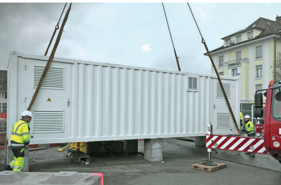
Platzieren des Baustromcontainers auf der Baustelle in wenigen Minuten
