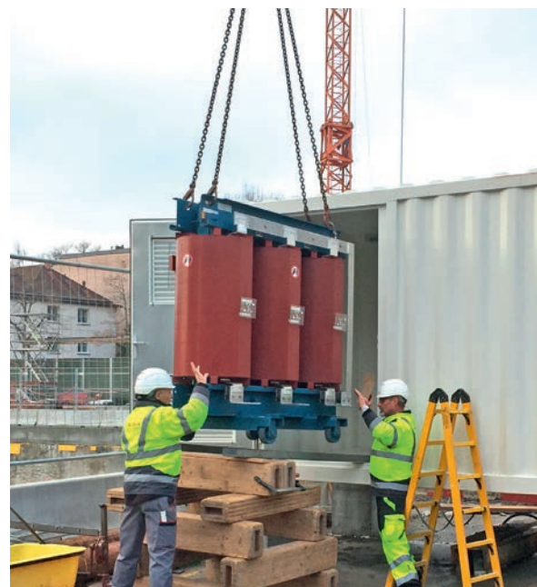
Einbau des Trafos vor Ort
